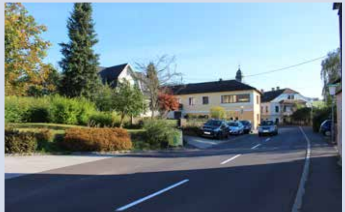
Durch die Errichtung des Gehsteiges wird der Schulweg sicherer.
