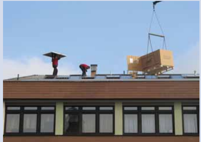
Arbeiten der Firma Helios beim Montieren der Photovoltaikanlage.
