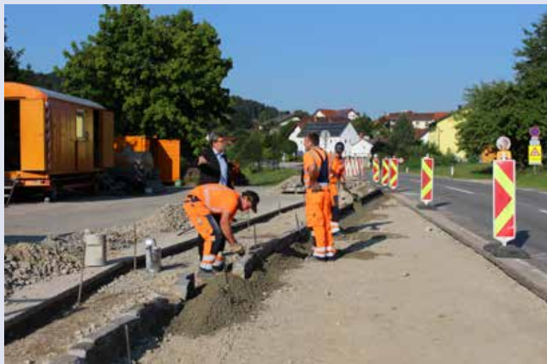
Der Bau der Busbucht am Sportplatz wurde bereits begonnen
