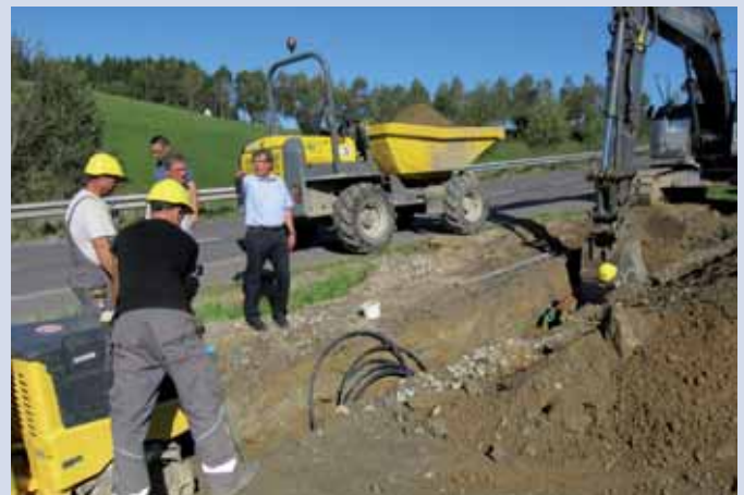
Die Fa. Teerag-Asdag bei den Arbeiten.
