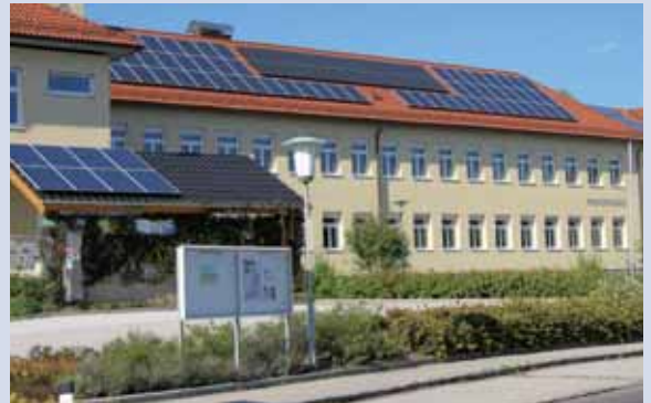
Photovoltaikanlage am Dach der Schule Gutau
