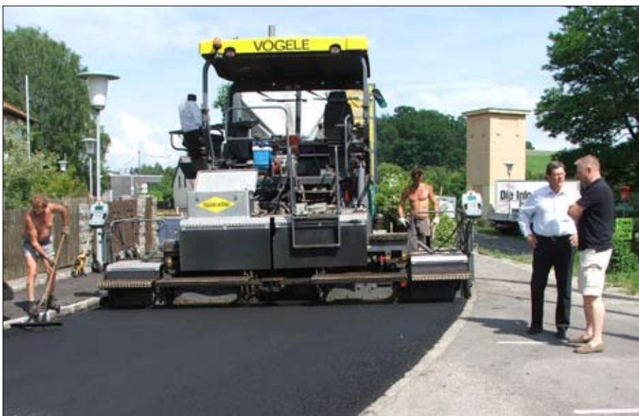
Firma Teerag Asdag hat die Arbeiten professionell durchgeführt.
