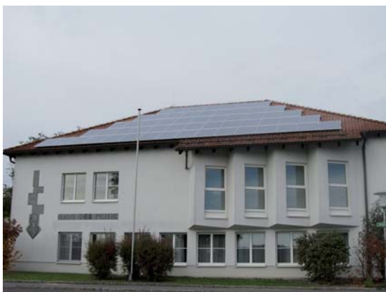
Die Photovoltaikanlage auf der Musikschule
