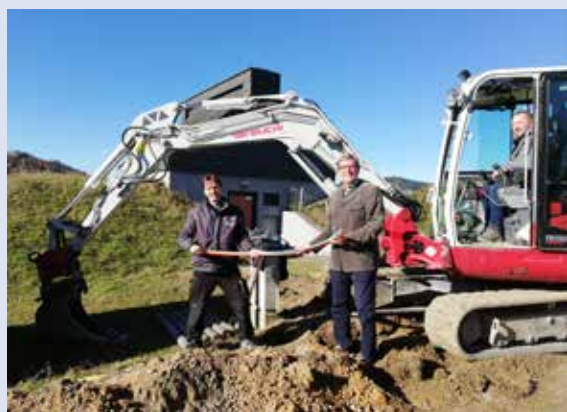
Breitbandausbau in Marreith
