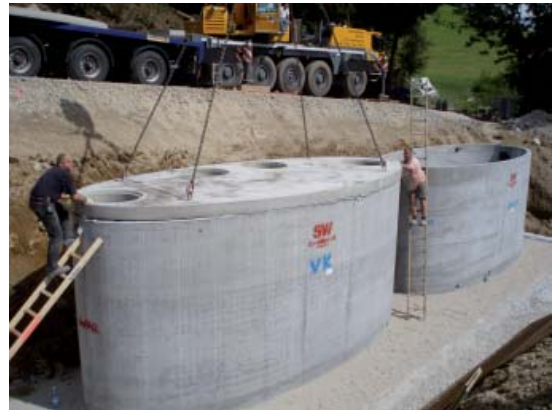
Ausbau des Kanalnetzes nach Fürling, Nußbaum, Stampfendorf und Neustadt €2,6 Mio.
