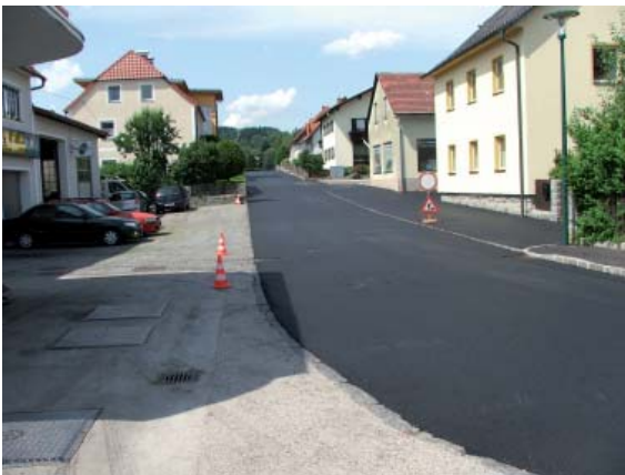
Sanierung der Gartenstraße, Höllergasse und Ringstraße €360.000,00
